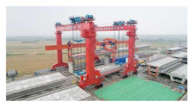
滨州日报/滨州网讯(记者 郭伟 通讯员 李苏报道)7月1日上午 11 时许,在津潍高铁无棣制梁场, 随着现场指挥人员"开架"指令的 下达,首孔长32米、重达700吨的 箱梁稳稳落在海兴特大桥807-808#墩上,标志着津潍高铁滨州 段首榀预制箱梁架设成功,开启了 箱梁架设施工新阶段。
