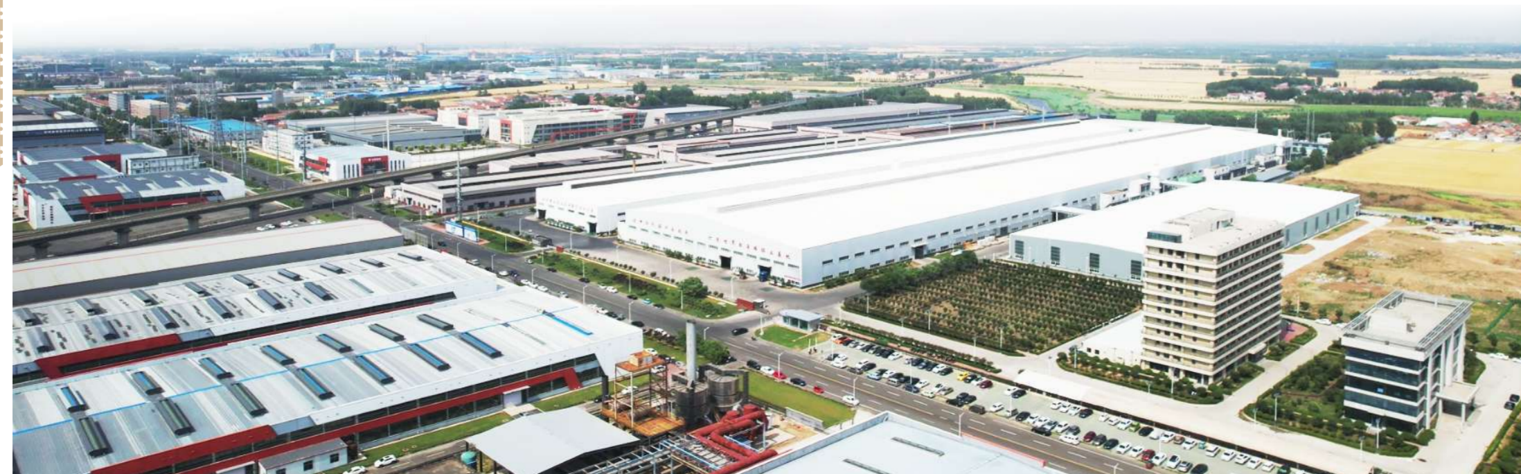
山东万通金属科技有限公司邹平分公司年产30万吨铝合金材料建设项目。
