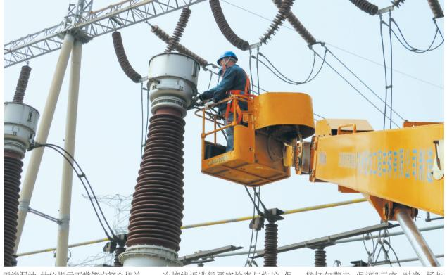
无渗漏油,油位指示正常等均符合相关 规定。安装完成后,国网滨州供电公司 对油箱及末屏、二次引线、金属膨胀器、
