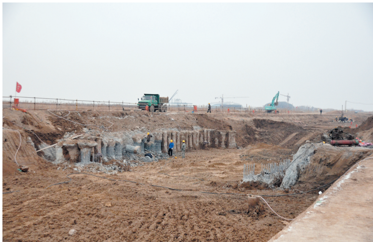
地下综合管廊项目建设现场。
