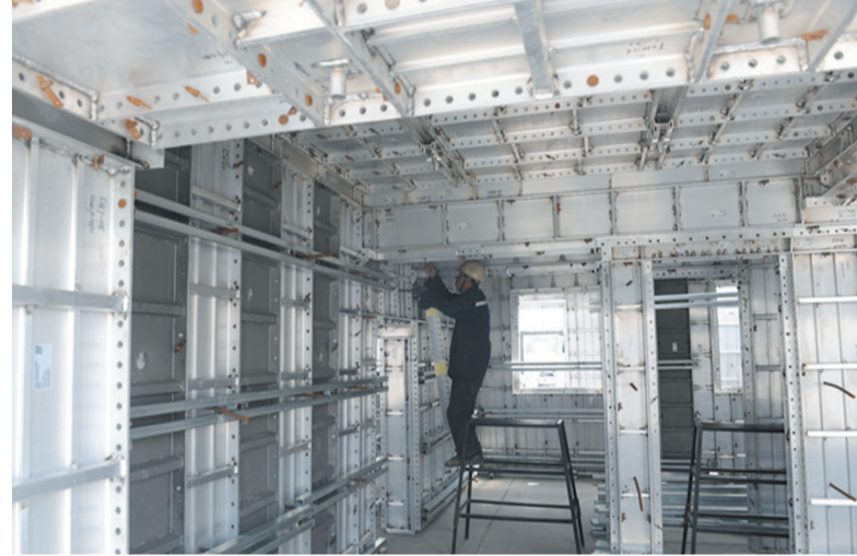
工人用铝模板建造房屋。铝模板绿色低碳,节能环保,可反复使用300多次,最终损耗不到千分之一。
