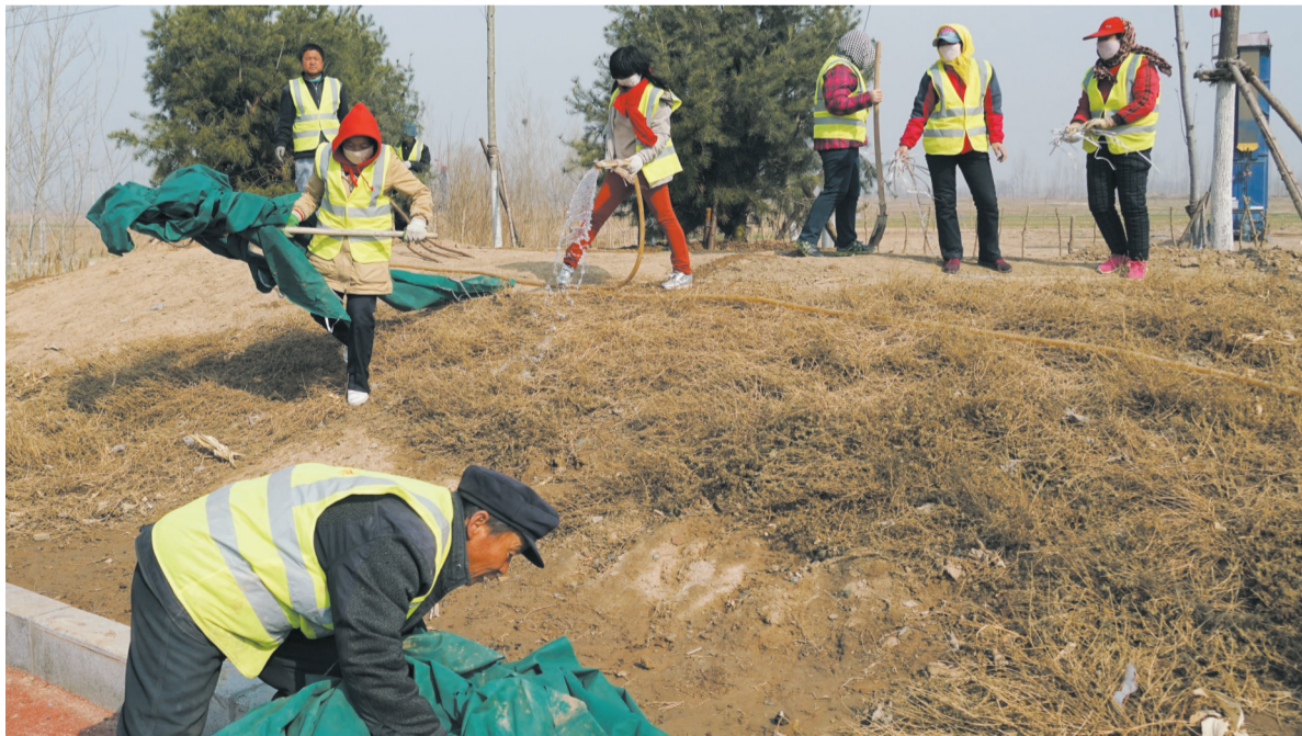
在绿地中打造雨水花园、铺设植草沟。
