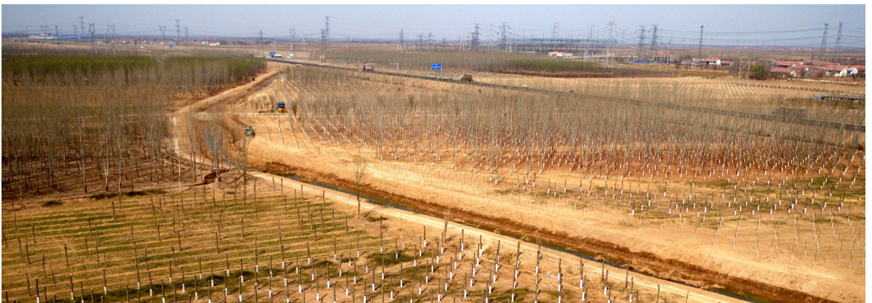
东外环北延205改线工程绿化正在紧张进行。
