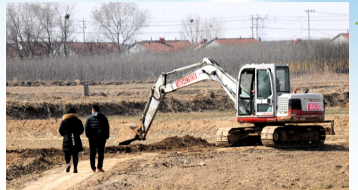
205国道1200亩土地已完成测量迁占,隔离沟全部完成,正在进行土地平整。
