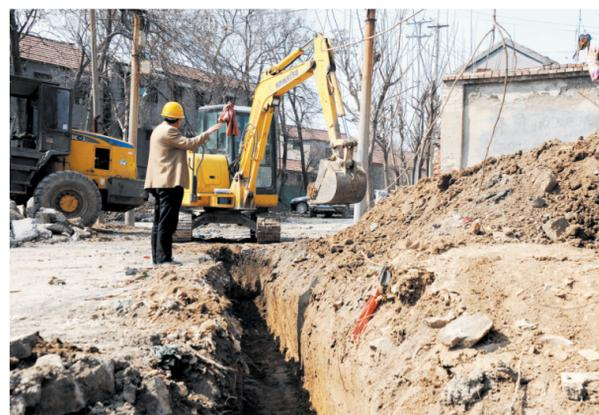
连日来,邹平县高新街道东范前村基础设施提升工程正在有序开展,10余辆工程车和60余名施工人员正在对村中主要街道供水、排水管网进行建设施工。
