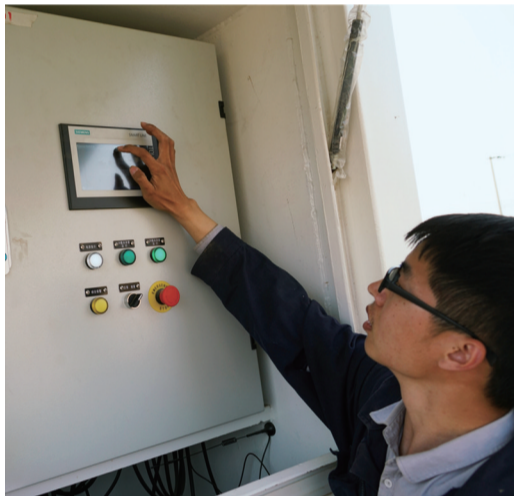
工作人员对污水处理情况进行观察。
