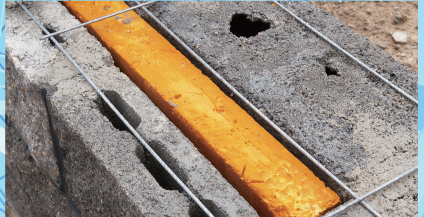
用装饰砌块作为保温层的围护结构,不仅保温节能,而且防火效果好。
