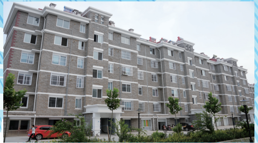
小区楼房均采用装饰砌块夹芯保温复合墙体技术,外形美观,实用节能。
