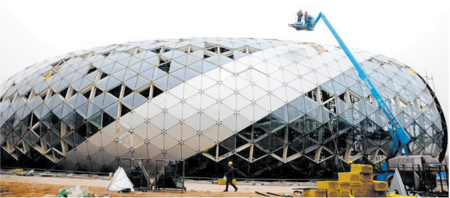
部分完成10%,三号鸟馆基础部分完成25%,四号鸟馆基础部分全部完成,钢结构工程全部完成,玻璃幕墙完成10%,管理用房主体及二次结构工程全部完成。”北海经济开发区水系贯通及综合治理工程PPP项目副经理赵鹏飞说。
