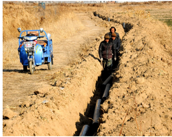
周家坊村和周王庄村正在实施贫困村节水灌溉工程。该项目面积1300亩,投资58万元。
