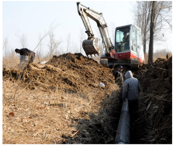
2万亩国家现代农业示范区高标准农田建设项目施工现场。
