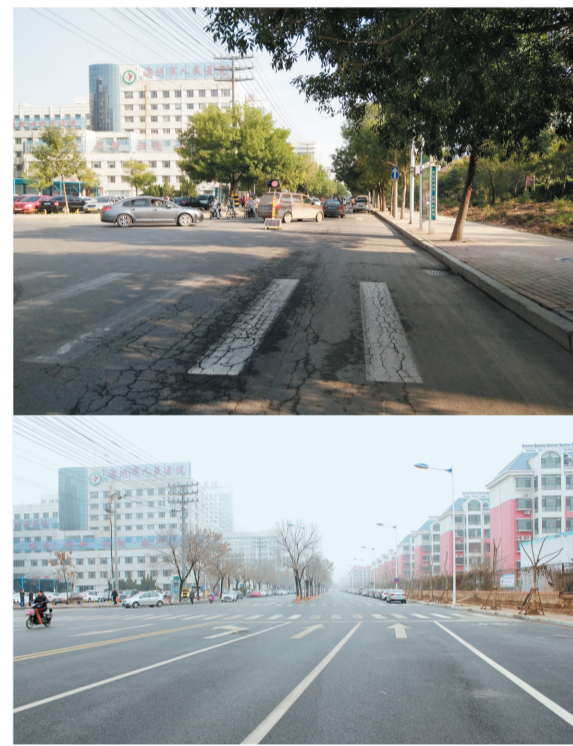
渤海八路改造前后。
