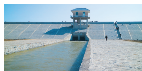
南水北调配套工程正式开闸引蓄长江水
