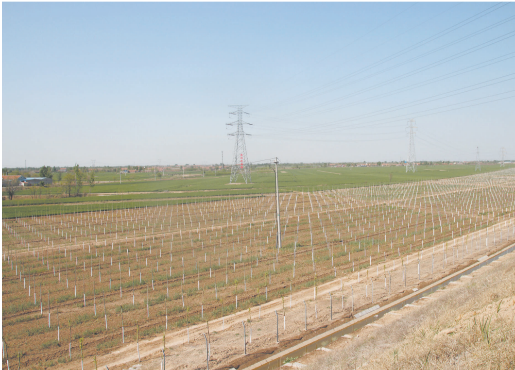
济滨东高速沿线绿化工程概貌
