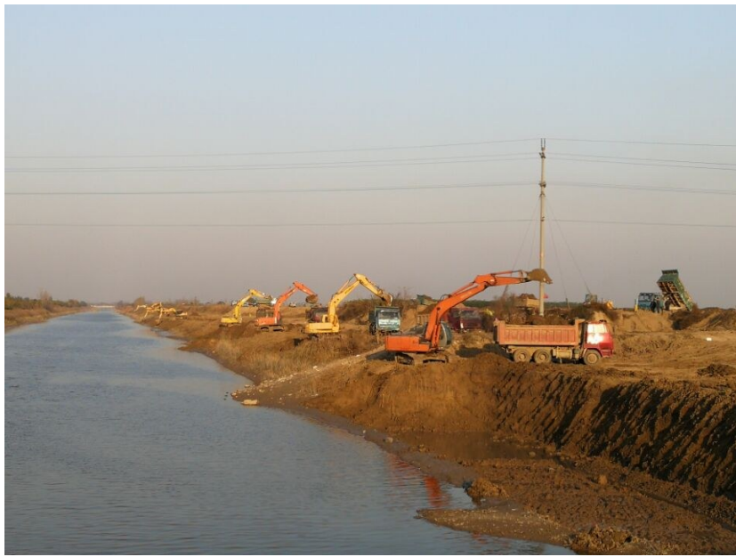
博兴县支脉河生态综合治理现场。
