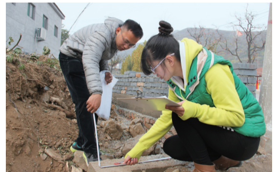
鲁东村美丽乡村建设工程现场跟踪审计。
