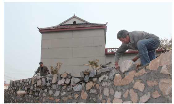
姜洞村进行排水沟建设。
