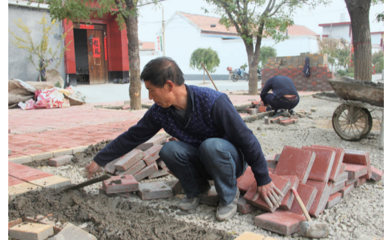
樊家村小广场进行硬化提升。
