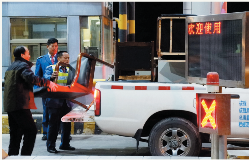
收费站办公设备陆续被撤走，收费设施将被彻底拆除。
